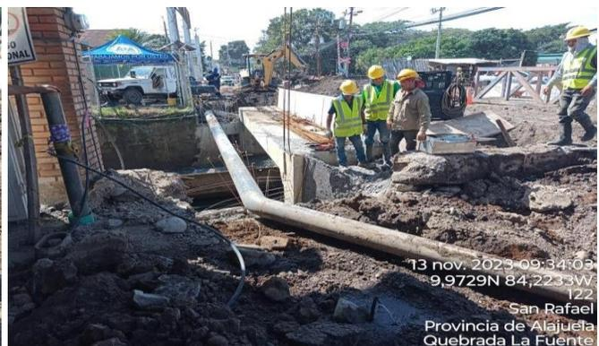
*Fotografías de relocación de tubería del Aya*
