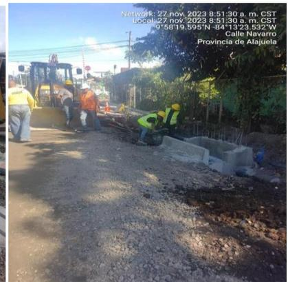
Fotografías, colocación de cemento para base estabilizada y trabajos en caja tragante
