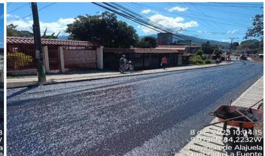
Fotografías, limpieza final para imprimir y colocación de cemento asfáltico
