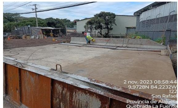
*Fotografías de construcción de la losa superior del puente*
